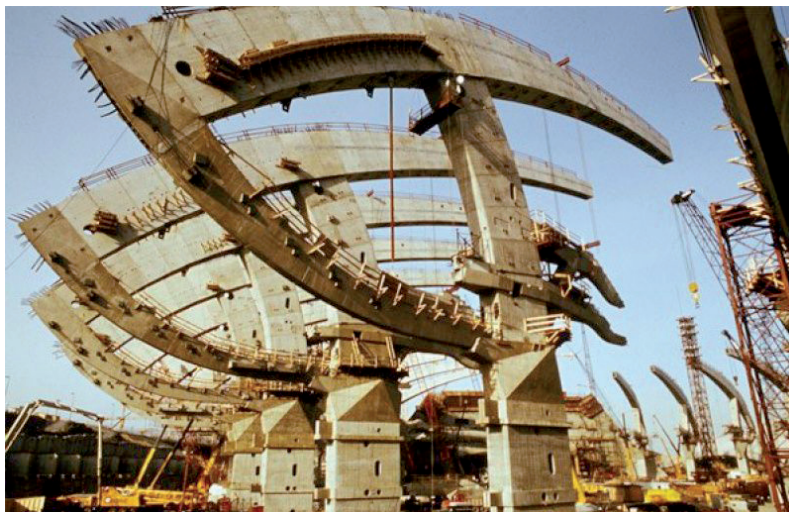
Fig. 6 Photographie du chantier des installations olympiques de Montréal. Source : Image libre de droits.
