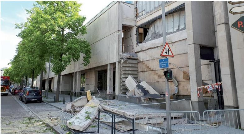
**Fig.4** : École d'architecture de Nancy. Vue de la façade après effondrement d'un pan de béton.
